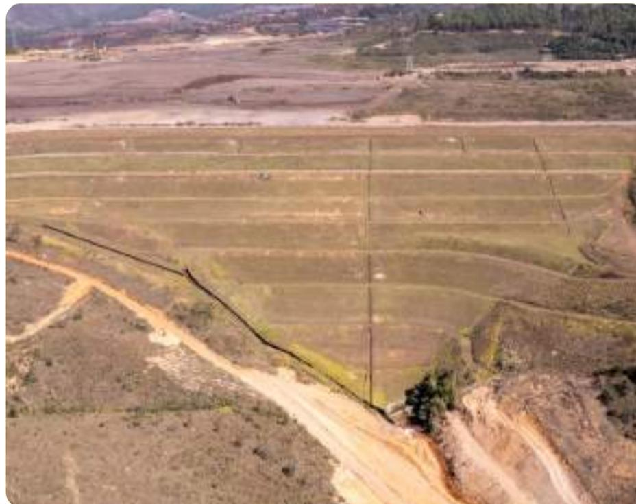
barragem Forquilha III no final de 2035, com a execução completa do projeto de descaracterização e a recuperação ambiental da área. A barragem possui Estrutura de Contenção a Jusante (ECJ) com Declaração de Condição de Estabilidade (DCE), capaz de reter os rejeitos no caso de um eventual rompimento.
